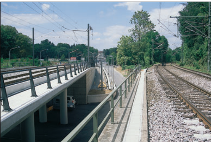
Die Netzverknüpfung am Pfühlpark erforderte einen gewissen Aufwand. Die Eisenbahntrasse in Hochlage wurde mit der ebenerdigen Straßenbahn durch eine Brücke verbunden, Rangiergleise (z.B. in Bildmitte) bieten betriebliche Gestaltungsmöglichkeiten.
