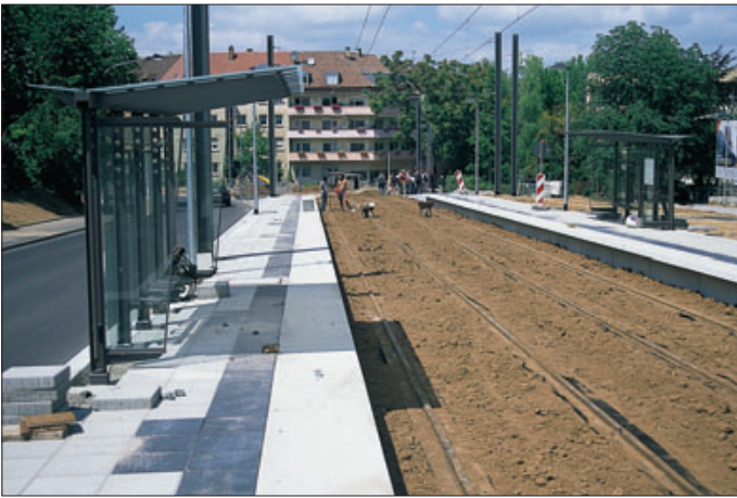
Umfeldverträgliche Gestaltung trotz Hochbahnsteig: Auf dem neuen Ostteil der Stadtdurchfahrt Heilbronn dominiert Rasengleis, auch im Stationsbereich. Das Bild der Haltestelle Finanzamt im Bauzustand Juli zeigt, dass die Anlage durch Geländemodellierung geschickt eingepasst wurde, damit die Gesamtstruktur trotz Bahnsteigkante auf 55 cm ü. SOK nicht zu wichtig wirkt.
