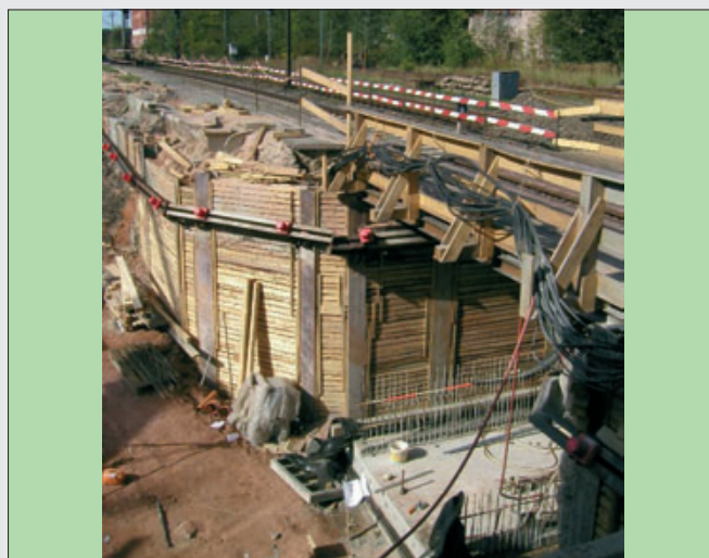
Wiederaufbau einer Bahnsteigunterführung in Neustadt b. Coburg
